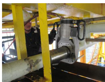
Crimping the Pyplok®
