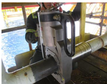
Crimping the Pyplok®
